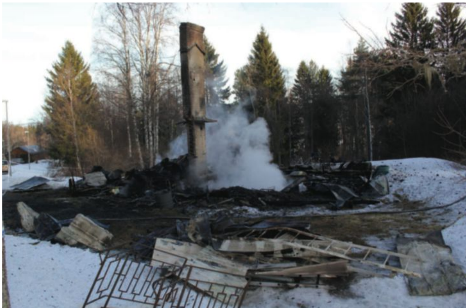
Dagen efter branden återstod bara en ruin av huset i Västanbäck.
